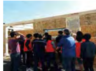
2일차 단열재 및 패시브 창호시공
